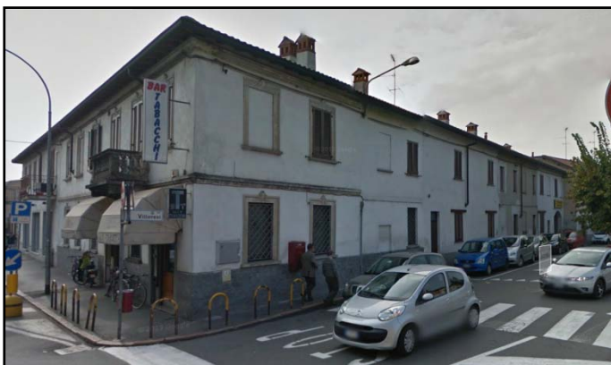
Fig. 41. Angolo delle vie Crivelli e Villoresi, vista verso sud ovest.
