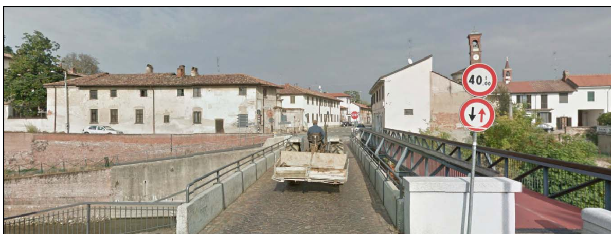
Fig. 34. Ponte Vecchio. Il centro visto dal ponte sul Naviglio verso est, con la villa Castiglioni a sinistra.
