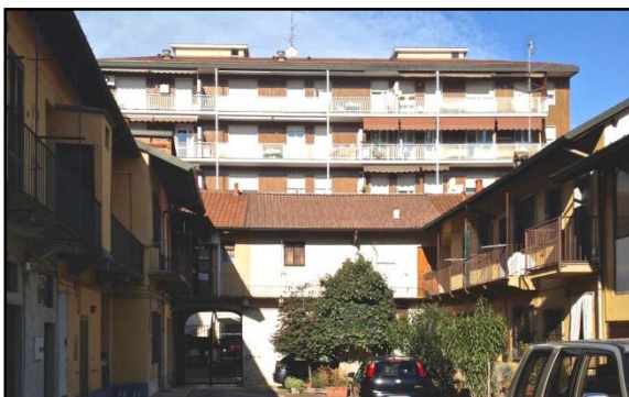
Fig. 13. L'interno di una corte di via Roma, lato sud, e sullo sfondo l'edificio di via Roma 92-100 in fregio al lato nord.
